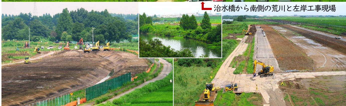
治水橋から北側の荒川と工事風景
